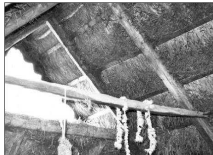
Kuklás ház látszati metszetrajza és padlása a füstnyílással (kukla) Buczko József etnográfus által rendelkezésre bocsájtott kép
